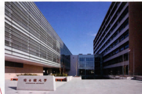
34号館 A 棟 (右)・B 棟 (左)
